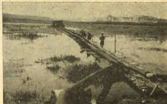
Rys. 9. Jezioro Niestusz przed usunięciem osadu — widok na pogłębiarkę i rurociąg pływający od strony wschodniej
