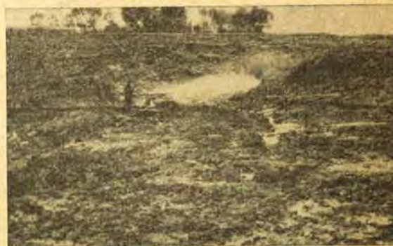
Rys. 12. Wodomiotacz wykonany sposobem gospodarczym przy pracy
