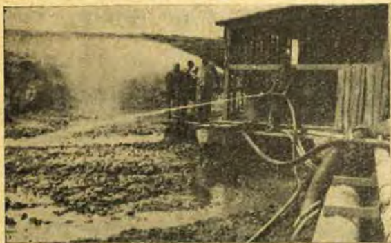
Rys. 11. Prowadzenie prac przy rozmywaniu osadu z pokładu pogłębiarki
