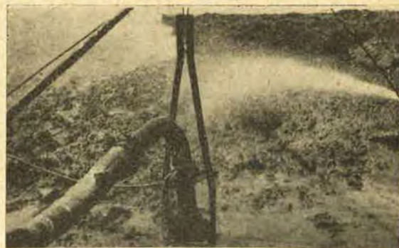
Rys. 10. Ssak z kolanem elastycznym na pogłębiarce z jeziora Niestusz
