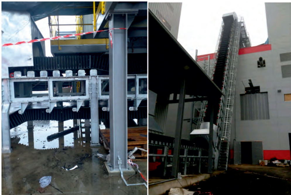
Rys. 13. Montaż taśmy na przenośniku Fig. 13. Installation of the belt on the conveyor
