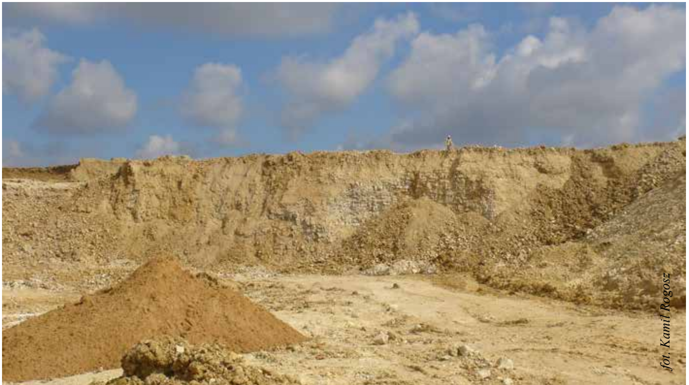
Kopalnia wapienia. Widok na ocios. Przygotowania do odstrzału
