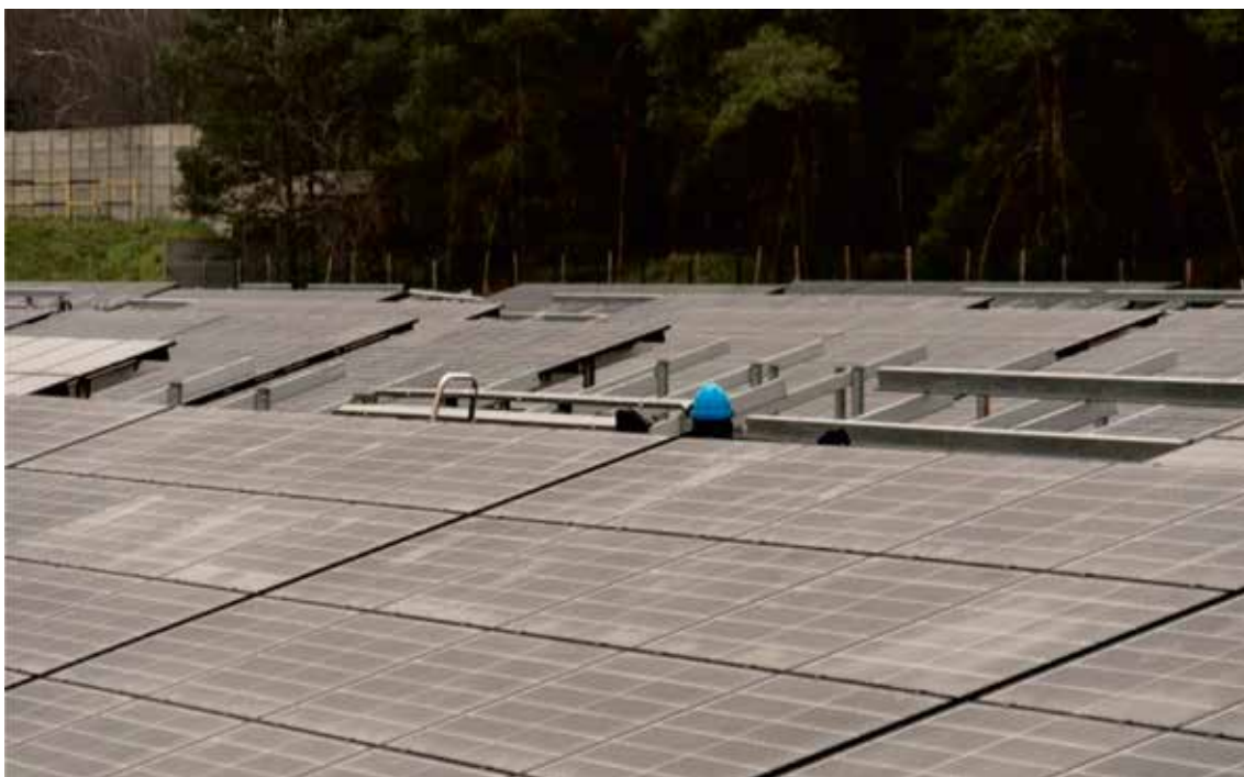
Rys. 2. Budowa elektrowni fotowoltaicznej na terenie MPWiK w Koninie (2021) (źródło: https://twwarta.pl/trwaja-prace-przy-budowie-farmy-fotowoltaicznej/ ) Fig. 2. The construction of the photovoltaic power plant in Konin (2021)
