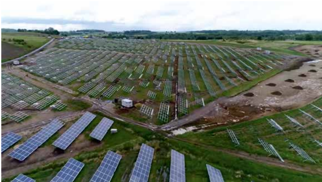
Rys. 1. Budowa elektrowni fotowoltaicznej w rejonie Bogatyni (2021) (źródło: https://www.facebook.com/TelewizjaBogatynia/videos/1520337278147988 ) Fig. 1. The construction of the photovoltaic power plant in the region of Bogatynia (2021)
