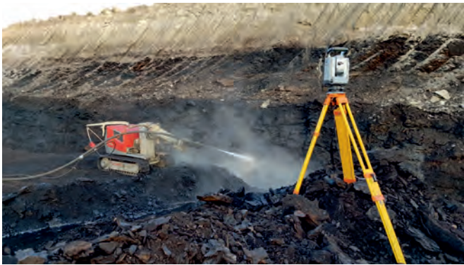
Rys. 1. Pomiar tachimetrem skanującym Fig. 1. Measurement with a spatial station
