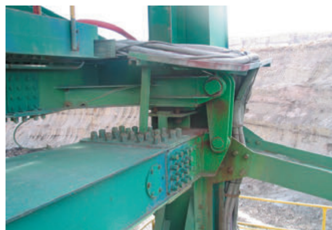
Rys. 4. Podparcie na wieży – koparka KWK1500
