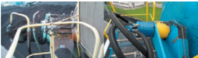
Rys. 4. Modernizacja napędu koła czepakowego (po lewej stronie przed modernizacją, po prawej stronie po modernizacji) [1]
