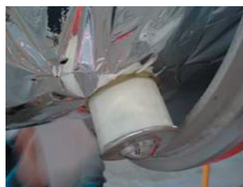
Rys. 8. Podpory ekranu termicznego – modele i obiekty rzeczywiste na montażu
