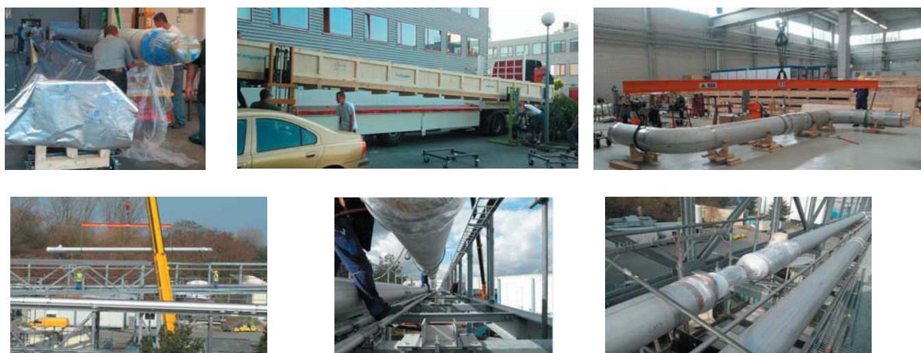
Rys. 5. Transport i montaż segmentów rurociągu
