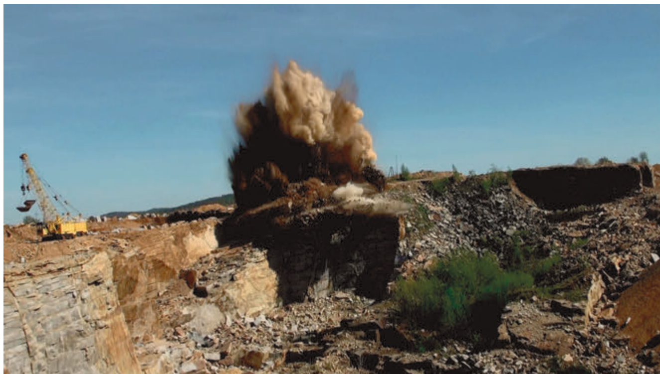
Roboty strzałowe w kopalni Paszowice
