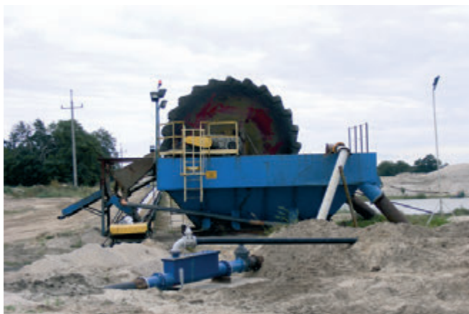
Fot. 3. Węzeł odwadniania z separatorem HM (hydrodynamicznym membranowym)
