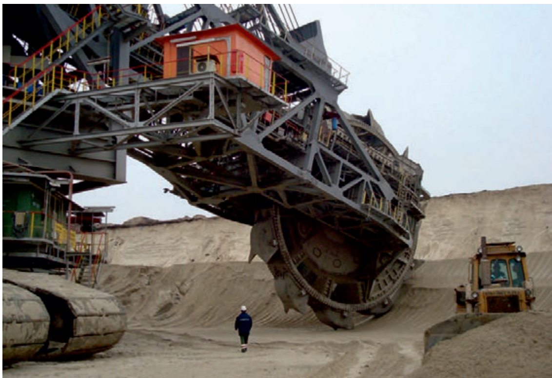
Fot. 6. Selektywna eksploatacja piasków koparką K-42 z I poziomu Pola Szczerców Fot. 6. Selective extraction of sands by K-42 wheel excavator from the I level of Szczerców Field
