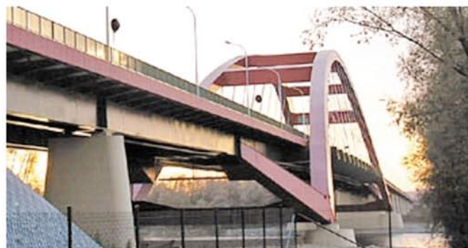
Rys. 5. Widok przęsła łukowego mostu w Puławach [3] Fig. 5 Arch bridge in Puławy [3]
