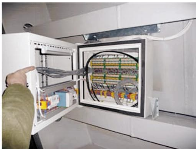
Rys. 7. Widok wnętrza serwera lokalnego zlokalizowanego na moście [3] Fig. 7 Inside view of local server localized on a bridge [3]
