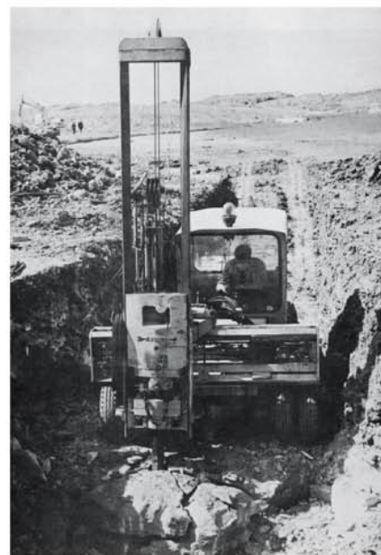
Rys. 5. Młot D 500 z bezbijakowym układem roboczym (Arrow Construction Equipment Ltd.)
