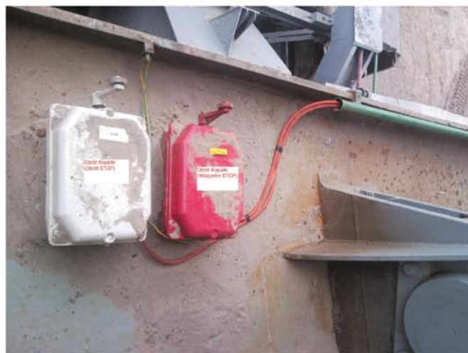
Rys.7. Wyłączniki krańcowe mechanizmu obrotu głównego. Wyłączenie obwodu obrotu (kolor biały). Obwód bezpieczeństwa „WSZYSTKO STOP” (kolor czerwony)
