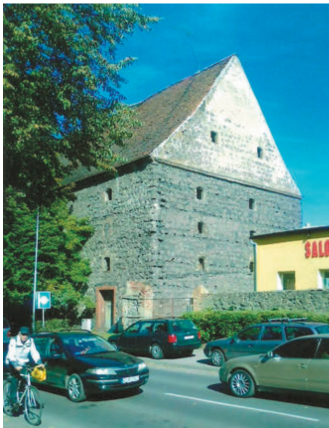
Fot. 3. Zbudowany z bazaltu stary spichlerz tzw. Dom Solny w Lubaniu Fot. 3. Old granary built of basalt, so-called House of Salt in Lubania City
