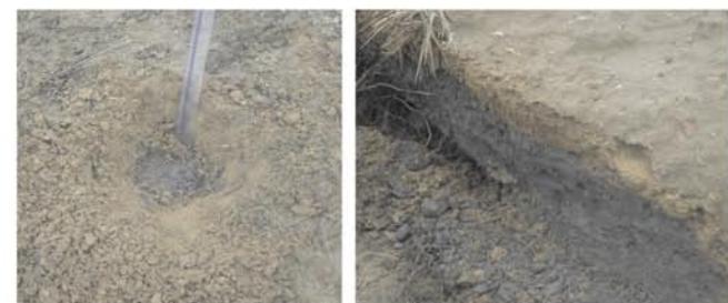
Fot. 1 i 2. Wykonana warstwa urodzajna o miąższości 12 cm (po lewej) i 8 cm (po prawej)
