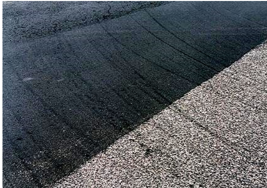
Fot. 3.2 Widok na fragment jezdni pokrytej asfaltem z dodatkiem ciemnego bazaltu oraz jasnego gabra [50]
