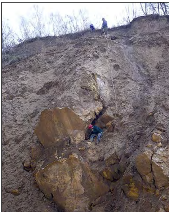
Rys. 4.9. Przygotowanie do strzelania szczelinowego w złożu dolomitu w Sławniowicach [96]
