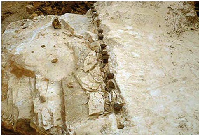
Rys. 4.45. Klinowanie ręczne w kopalni Sławniowice [96]
