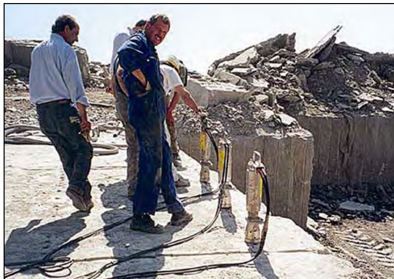
Rys. 4.28. Praca rozłupiarką Darda [24]
