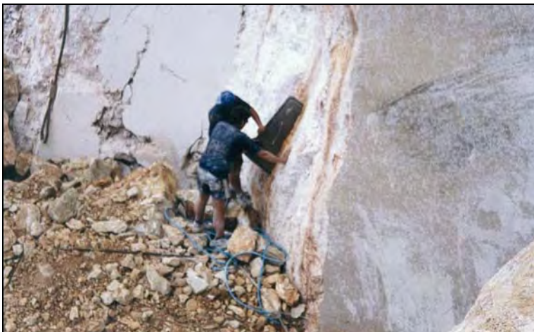
Rys. 4.59. Wykorzystanie poduszki powietrznej do odpajania bloku [60]
