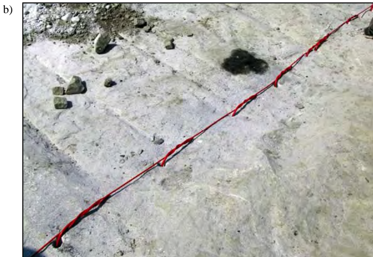
Rys. 4.8. Odspojenie monolitu za pomocą lontu detonującego: a) w płaszczyźnie poziomej; b) w płaszczyźnie pionowej (fragment sieci lontu)
