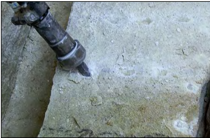
Rys. 4.46. Wykuwanie gniazd pod kliny, kopalnia Radków – piaskowiec
