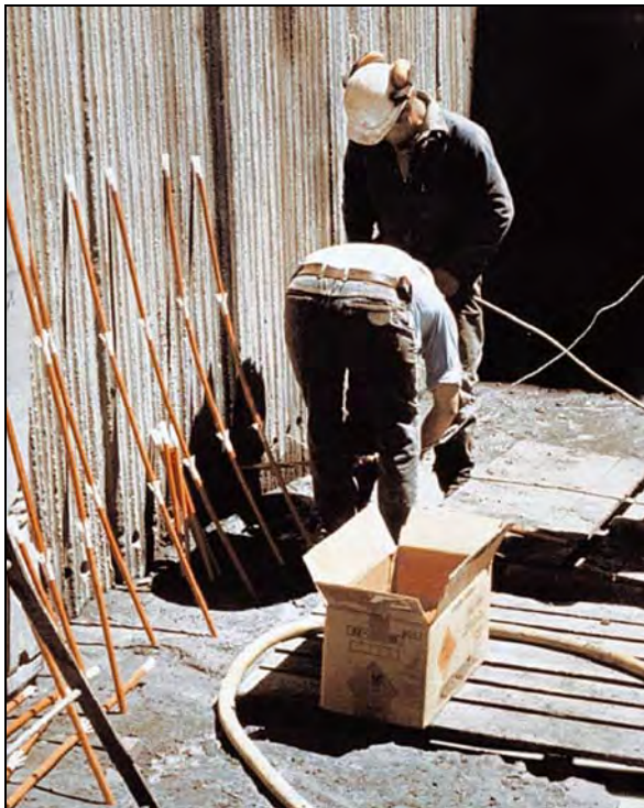
Rys. 4.6. Załadunek ręczny MW do otworów z metody fińskiej [74]
