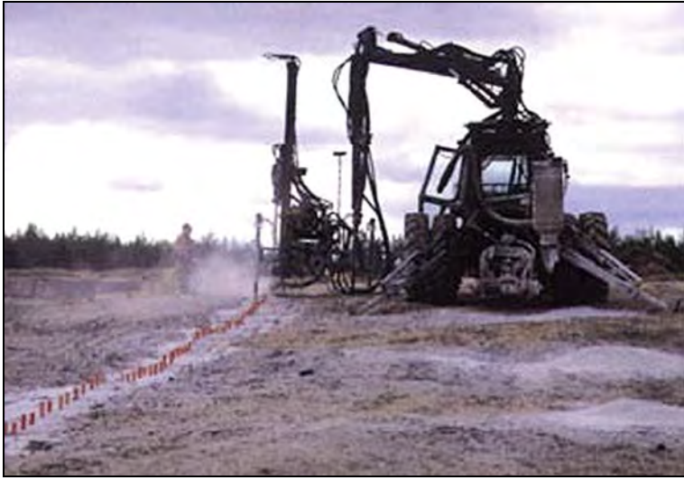
Rys. 4.7. Załadunek mechaniczny MW do otworów z metody fińskiej [74]
