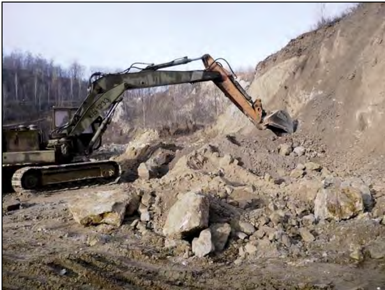
Rys. 7.1. Odsłanianie bloków dolomitu przez koparkę [96]
