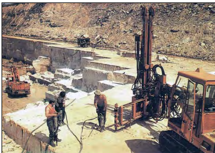
Rys. 4.34. Wiercenie otworów za pomocą perforatora oraz klinowanie za pomocą rozłupiarek – kopalnia Szydłowiec (piaskowiec)
