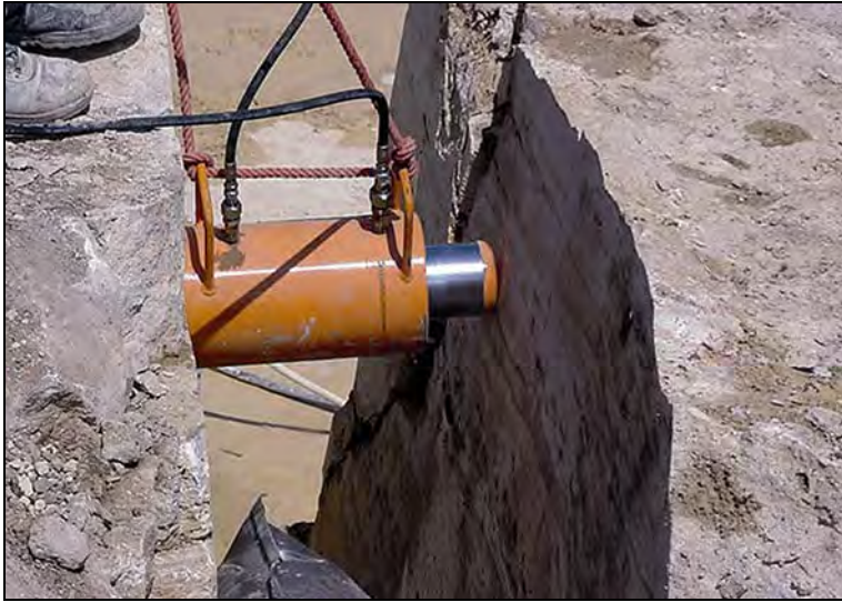
Rys. 4.60. Wykorzystanie siłownika hydraulicznego w operacjach pomocniczych przy wydobyciu trawertynu w Jordani [60]
