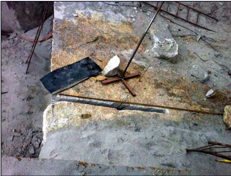
Rys. 4.42. Wykonanie wrębu za pomocą palnika termicznego w kamieniołomie granitu Skalimex
