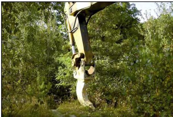
Rys. 4.53. Koparka z osprzętem typu pazur w kopalni piaskowca blocznego Żerkowice [60]
