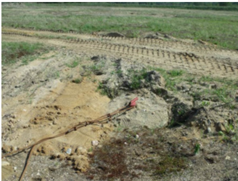
Fot. 37 Mocowanie liny do kierowania pozycją koparki ssącej (źródło: A. Witt 09.05.2011)
