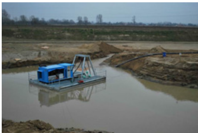
Fot. 16 Głowica urabiająca firmy Dragflow umieszczona na platformie firmy Wichary (źródło: www.Wichary.eu )
