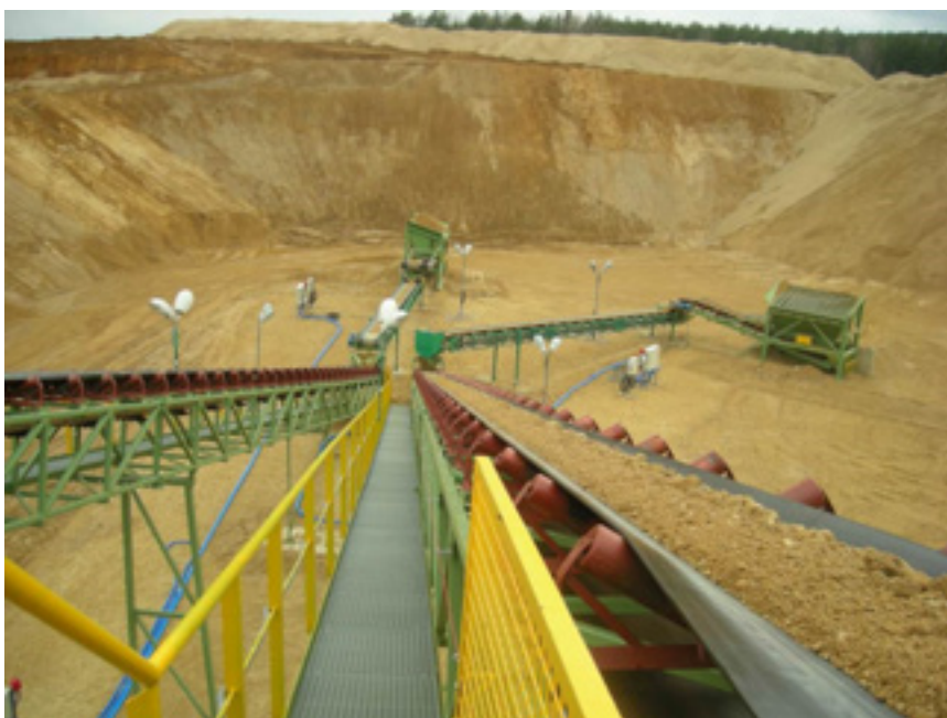
Fot. 2 Węzeł załadunku urobku z warstwy niezawodnionej na przesiewacze (źródło: A. Witt 4.11.2007)
