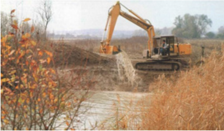
Fot. 28 Eksploatacja piasków i żwirów koparką podsiębierną (źródło: internet)
