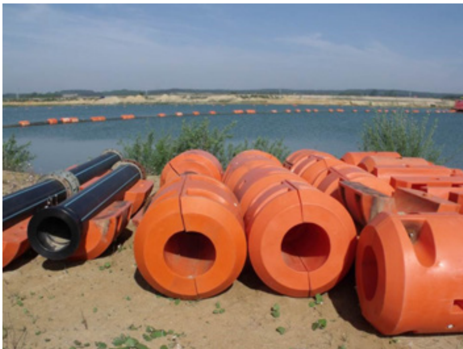
Fot. 73 Rurociąg transportujący urobek od koparki ssącej na ład oraz pływaki, do których jest przymocowany (źródło: A. Witt 09.05.2012)
