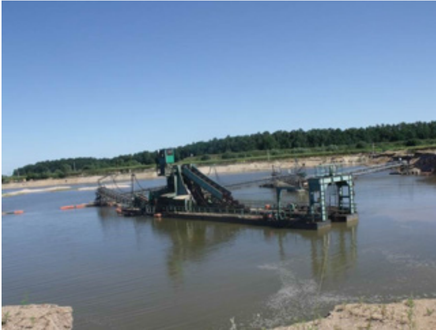
Fot. 5 Pływająca koparka łańcuchowa firmy Röhr typ KS 160 (źródło: A.Witt 10.08.2011)
