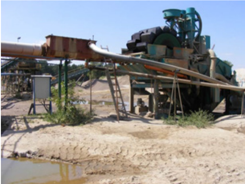
Fot. 87 Widok hydrokorektora membranowego Wariant II (źródło: Z. Schmidt 2007)
