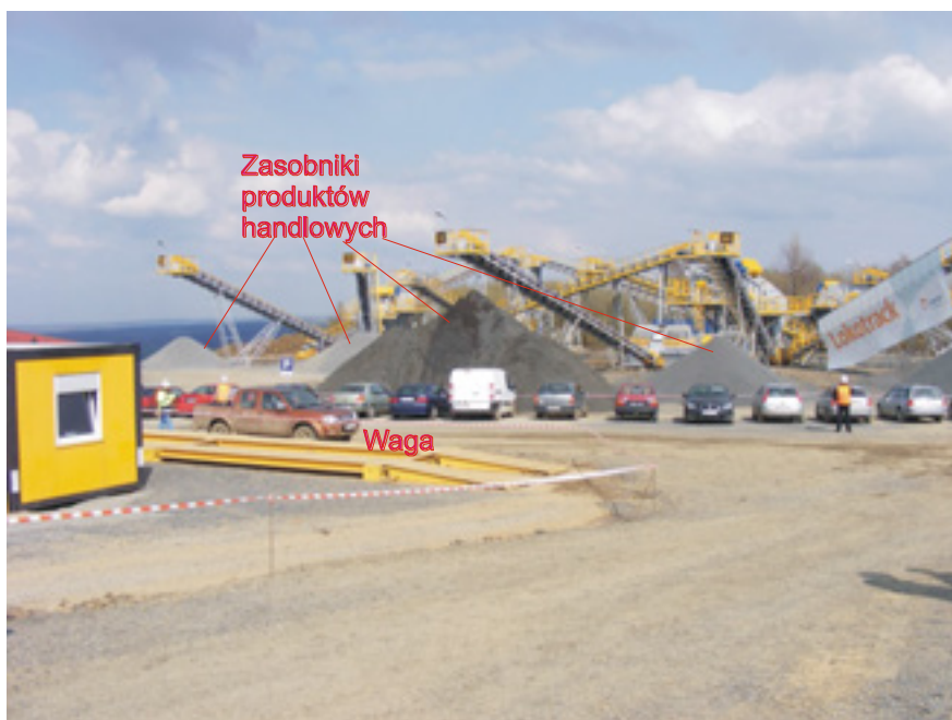
Fot. 77 Terenowe zasobniki produktów handlowych formowane przenośnikami taśmowymi (źródło: Z. Schmidt 01.06.2012)
