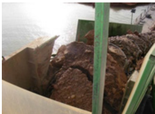
Fot. 50 Czerpak koparki wypełnionej zaglinionym piaskiem i żwirem (źródło: Z. Schmidt 02.12.2011)
