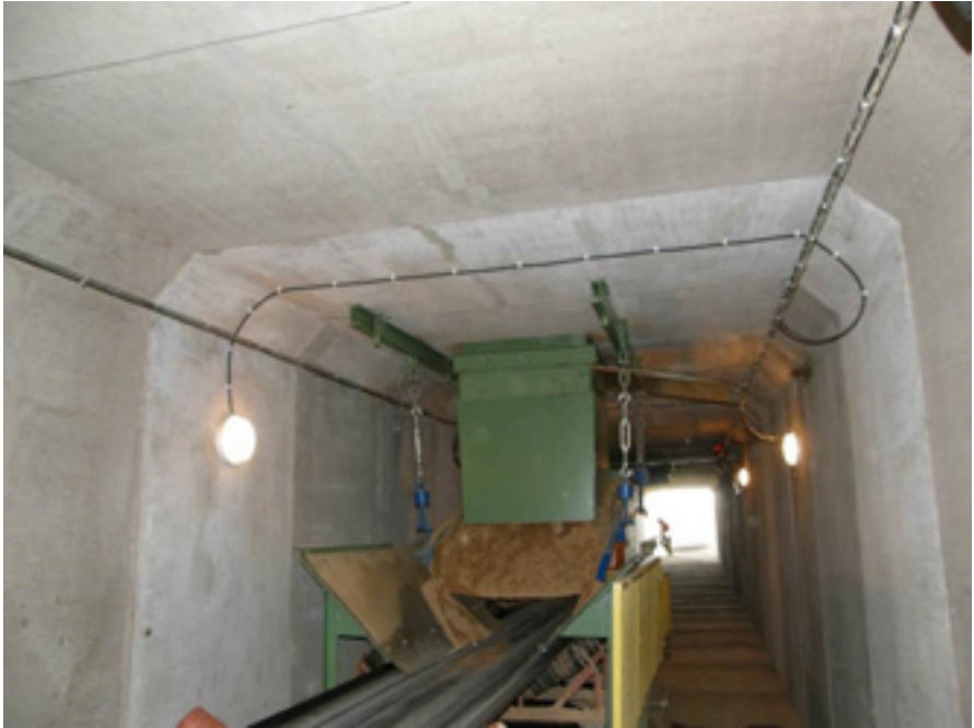
Fot. 80 Tunel pod zasobnikiem produktów handlowych (źródło: A. Witt 07.2008)
