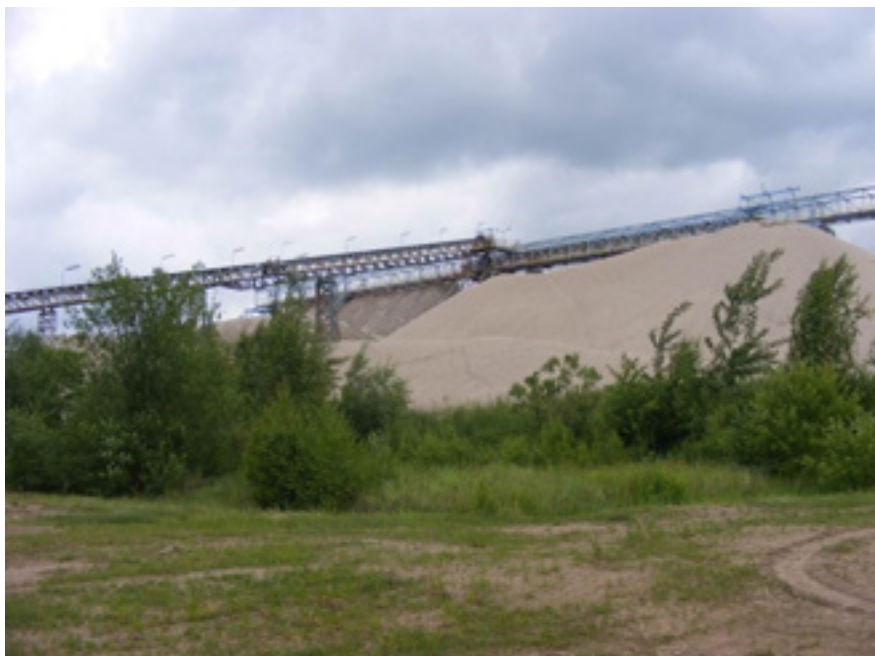
Fot. 76 Składowanie produktów handlowych przenośnikami z estakady (źródło: A. Witt 01.06.2012)
