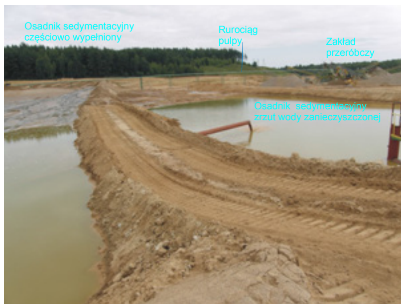
Fot. 64 Zbiorniki sedymentacyjne w kopalni piasków i żwirów (źródło: A. Witt 18.09.2008)
