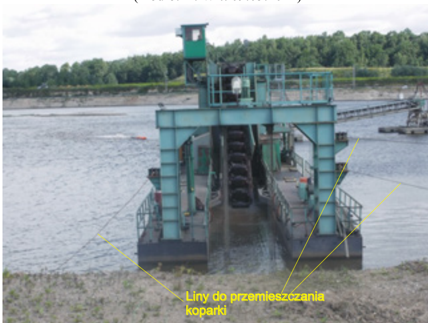
Fot. 38 Połączenie linami ustalającymi położenie pływającej koparki łańcuchowej (źródło: A. Witt 09.08.2011)
