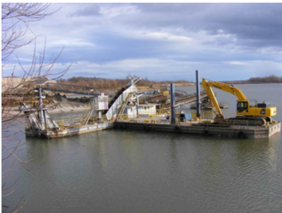
Fot. 72 Punkt przeładunkowy urobku usytuowany w zbiorniku wodnym (źródło: A. Witt 27.12.2012)
