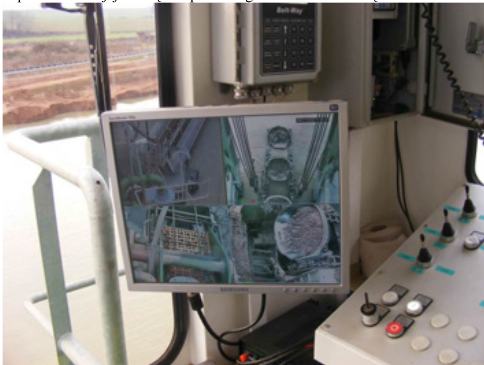
Fot. 24 Monitor w kabinie sterowniczej pływającej koparki łańcuchowej (źródło: A. Witt 02.12.2011)
