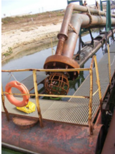
Fot. 18 Głowica koparki ssącej (źródło: Z. Schmidt 01.10.2012)
