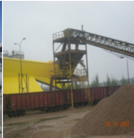
Fot. 20. Załadownia produktów handlowych na wagony (A. Witt, 02.10.2007 r.)
