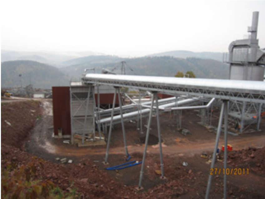
Fot.21. Zakład przeróbczy wyposażony w instalacje odpylające
