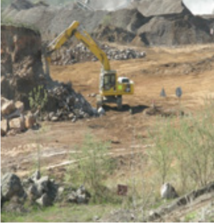
Fot. 15. Koparka z młotem hydraulicznym (A. Witt, 20.04.2009 r.)
