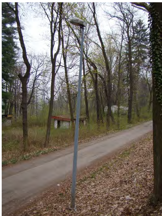
a) Oprawa SGS (wzdłuż głównej drogi)
