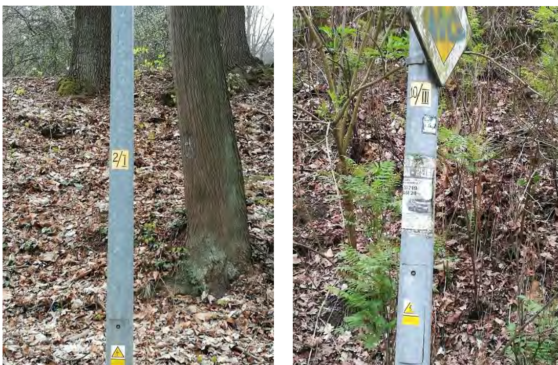
Rys.4.5. Oznaczenie na słupach oświetleniowych ulicy Kombatantów
