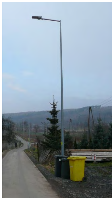
Rys. 2. Nowe oświetlenie drogowe w Barlinku, części wsi Radłówka, zainstalowane w 2017 r. (Ośmiokątne słupy stalowe ocynkowane z oprawami LED o mocy 30 W); pierwsze oświetlenie drogowe LED w gminie Lwówek Śląski.
