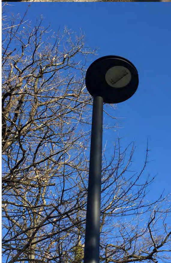
Nowe oprawy wraz z czujnikami (Park Vila Zora)
