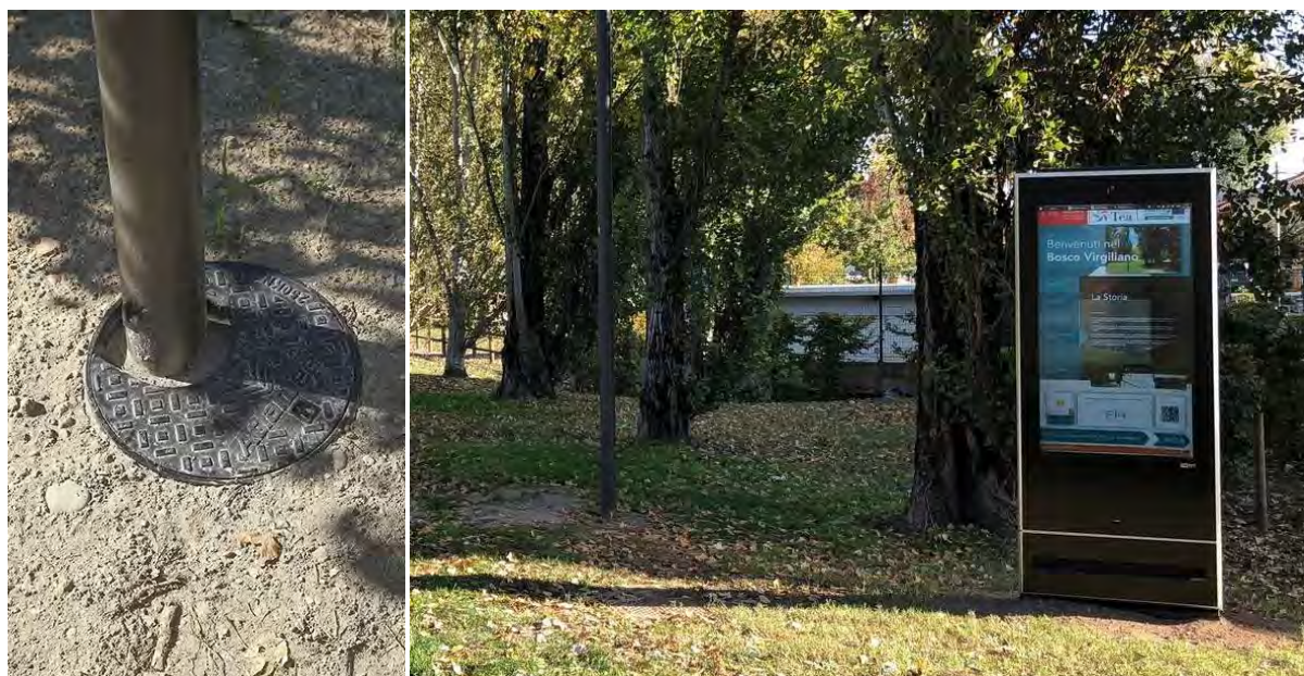
Fundament „śrubowy” i totem multimedialny
