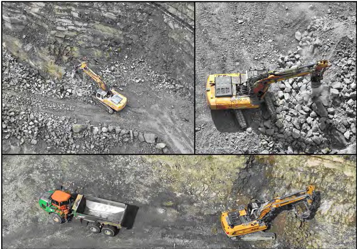
Fot. 5. Eksploatacja w wyrobisku prowadzona jest systemem ścianowym oraz zabierkowym, przy pomocy młotów hydraulicznych zamontowanych na koparkach gąsienicowych
