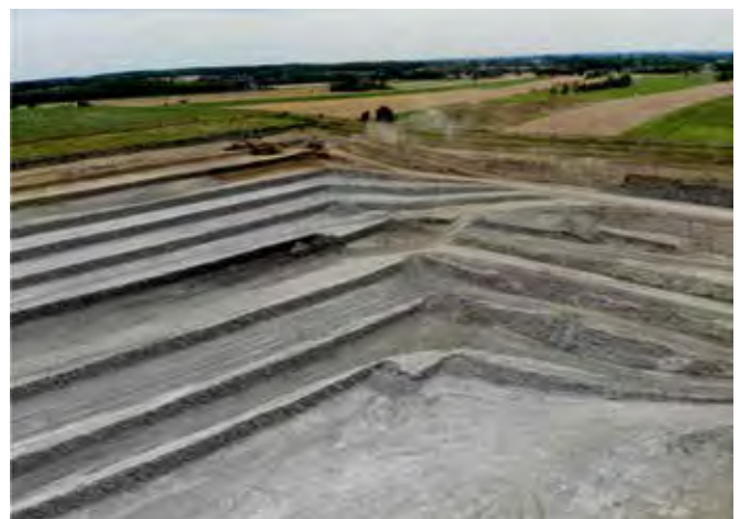
Fot. 2. Eksploatacja złoża i zdejmowanie nadkładu
